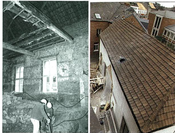
Im Jahre 1989 begannen die Sanierungs- und Umbauarbeiten
